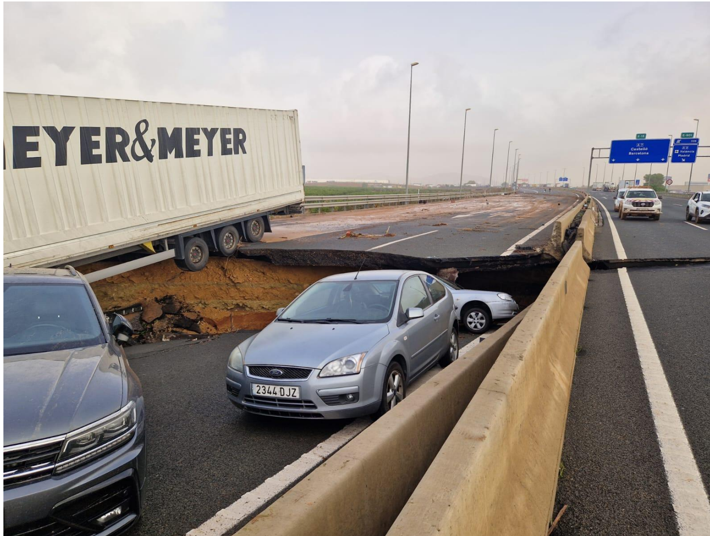
Viaducto colapsado
